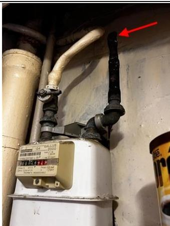
Photo n° du Compteur Gaz avec la canalisation obturée et soudée
